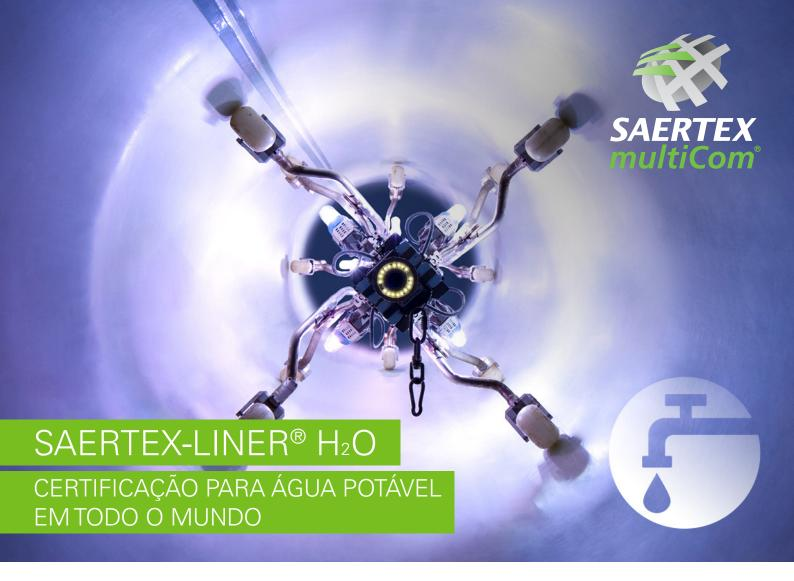
Resistente à pressão, higiênico, premiado: O SAERTEX-LINER® H<sub>2</sub>O oferece características mecânicas superiores para a reabilitação não destrutiva de linhas de abastecimento de água potável usando o processo CIPP com cura UV. Nosso revestimento de tubos de GRP curado por UV foi aprovado em mais de 13 países e ganhou o Prêmio de Inovação ISTT em 2019. Ele está disponível em duas opções de projeto:
